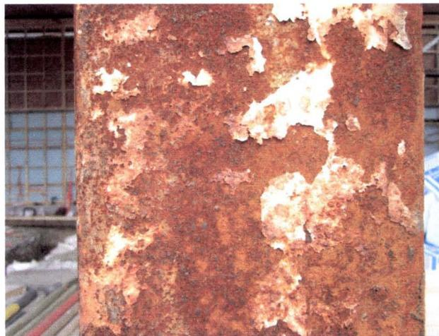
Foto 2. Detalle de perfiles metálicos con óxido.
